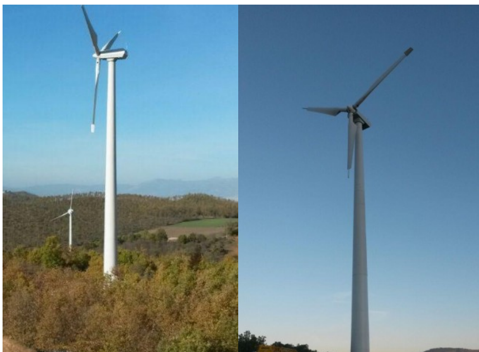
Vista dell'impianto da 200kW in località Serra Alta
